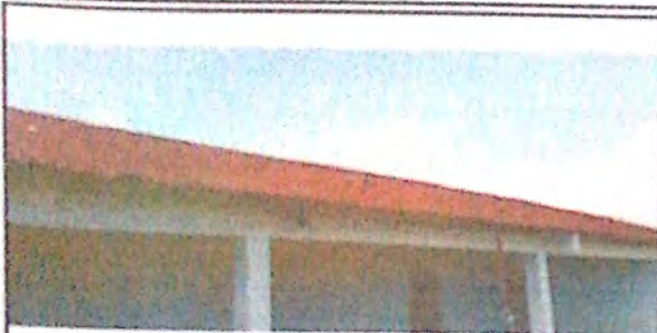
Foto 1: Sustitución de lámina
