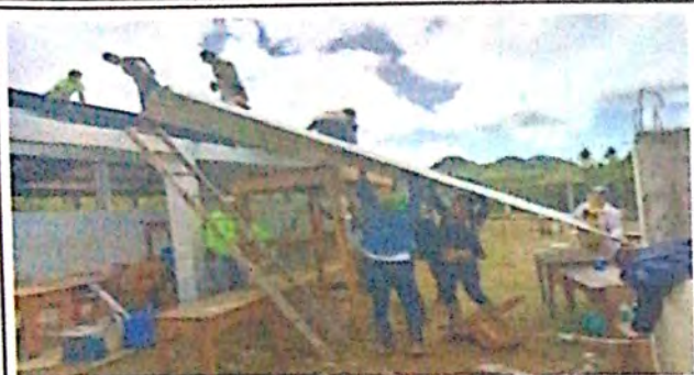
Foto1: cambio en techado
