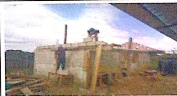
Foto 4: ampliacion de cocina
