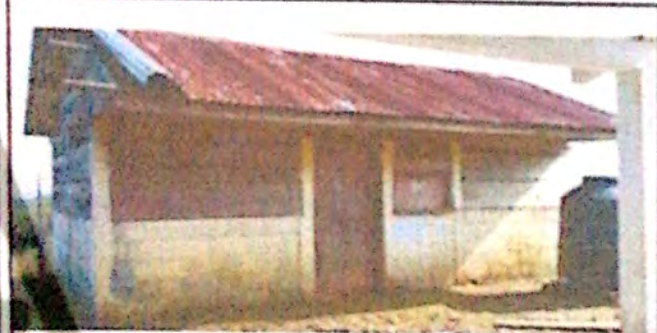
Foto 3: Sustitución de puerta
